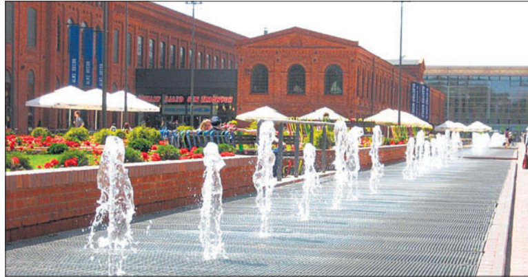
Alte Textilfabriken erstrahlen in neuem Glanz.
